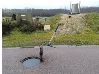
Rue du Moulin – regard amont PR « Principal » avec débordement sur voirie
