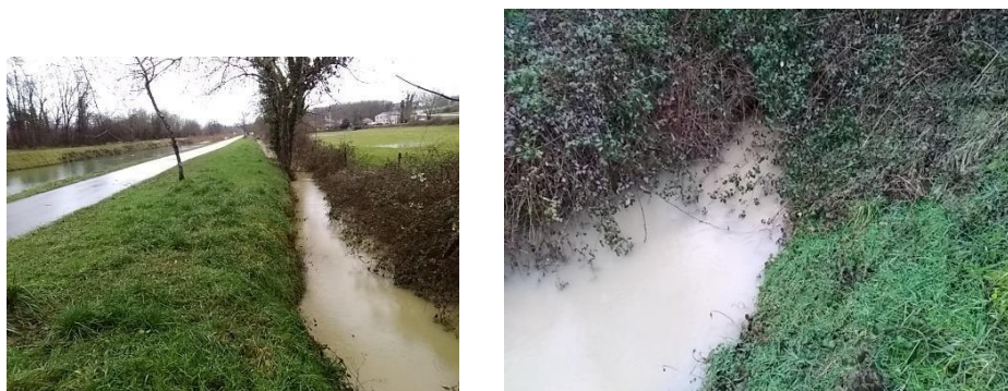
Contre-fossé en charge et lieu d'arrivée de RT-DO3 et RT-DO2
